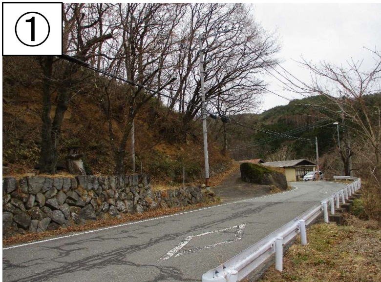
① 現道の状況(急カーブにより視認性が悪い)
