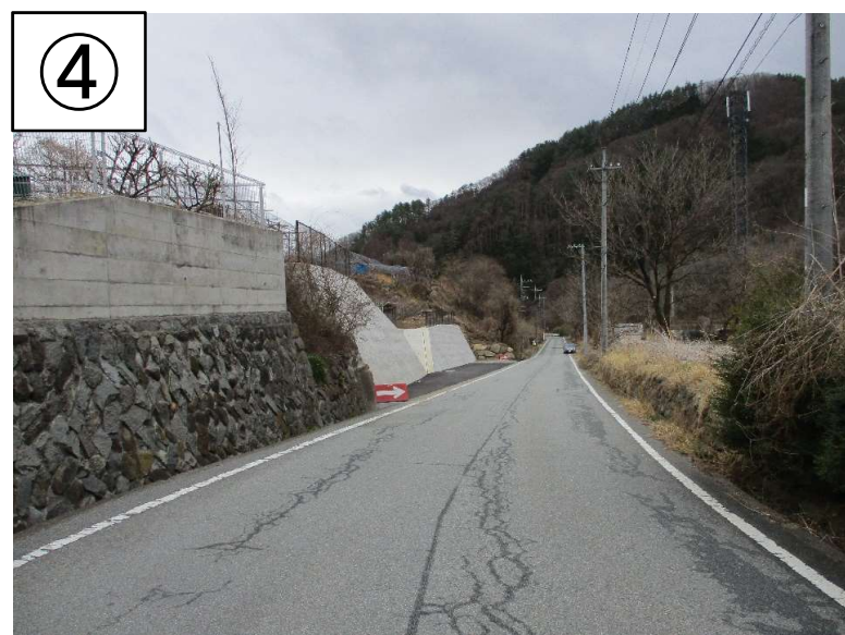
④ 現道の状況(施工済み箇所)
