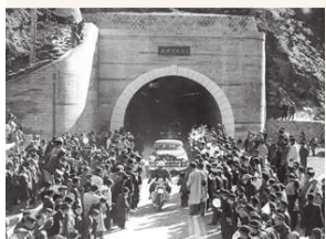
新笹子トンネル開通
