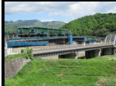
富士橋(建設中)
