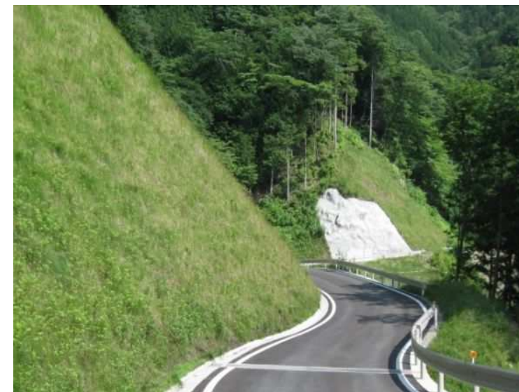
④ 法面保護工の状況
