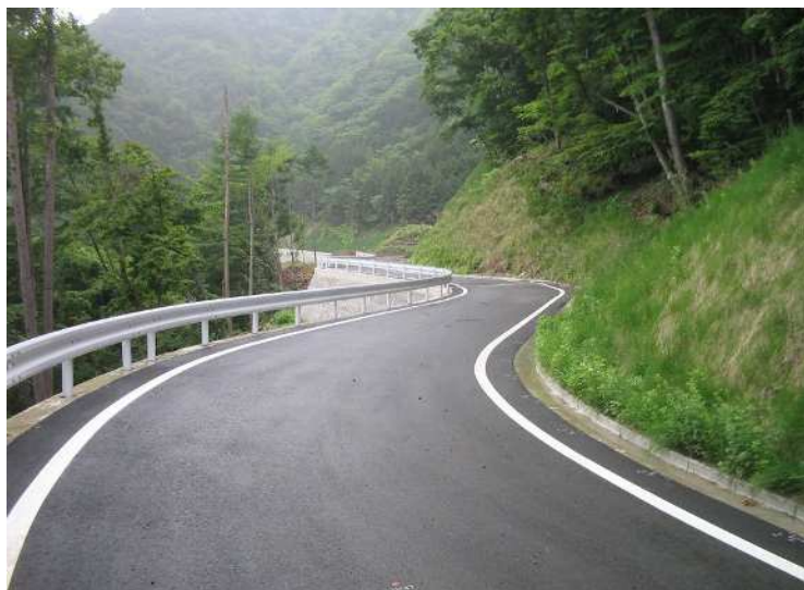
① 完成済区間の状況
