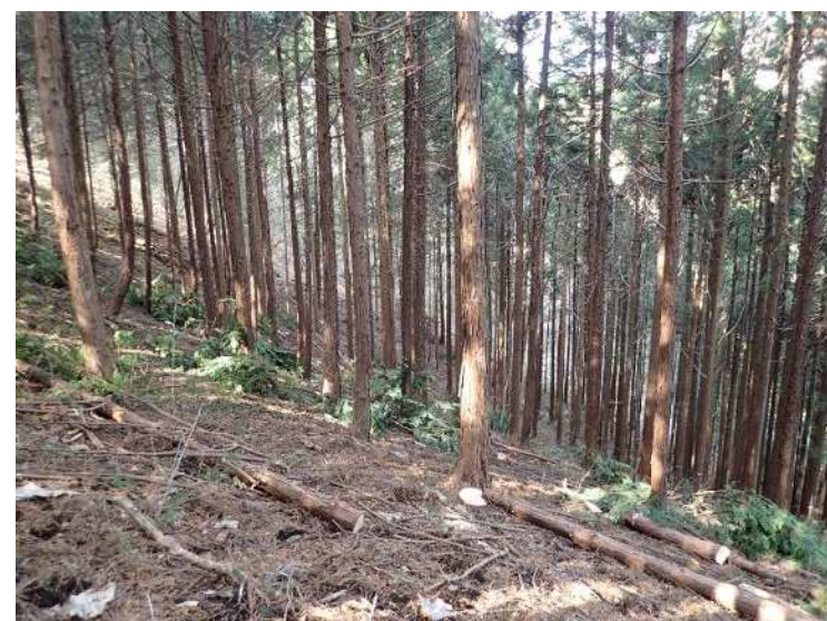
② 林道沿線における森林整備の状況（実施後）
