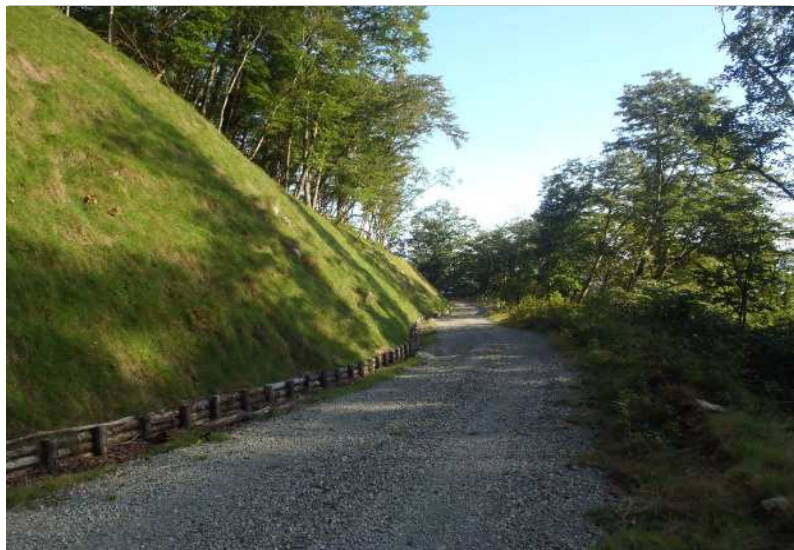
①林道の開設状況
