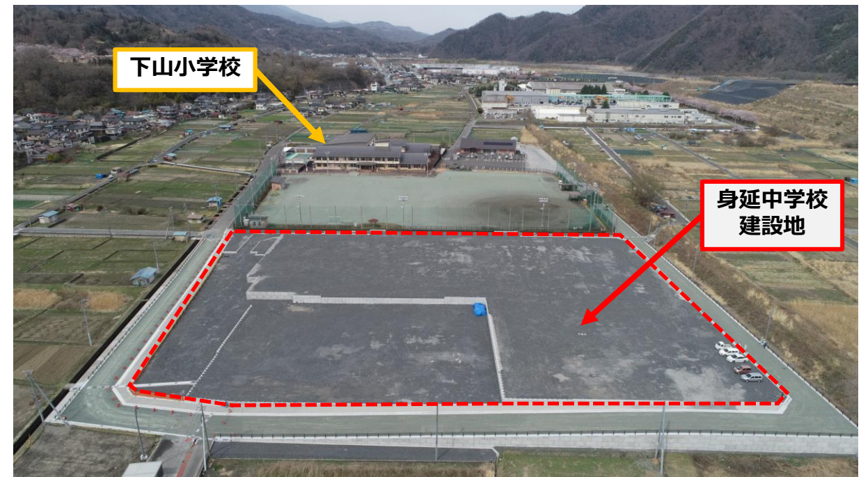
身延中学校建設地 令和4年3月28日撮影
