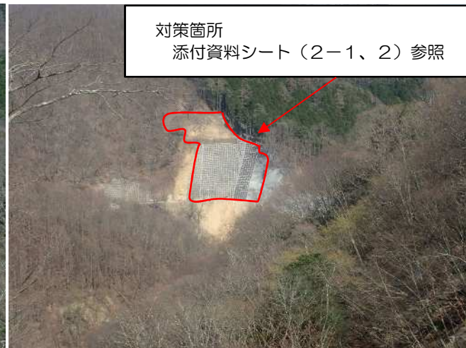
③ 対策完了状況
