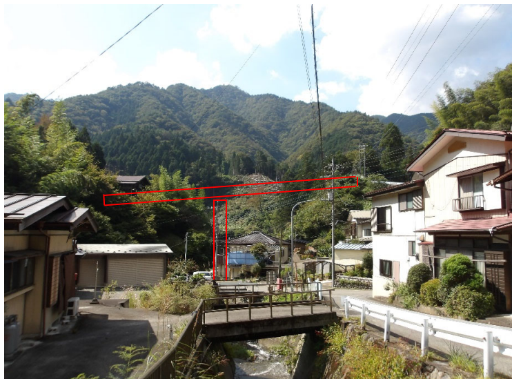
① バイパス橋梁区間
