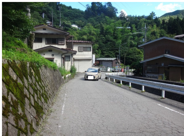
③ 幅員が狭く、乗用車1台分が通れる幅員しかない
