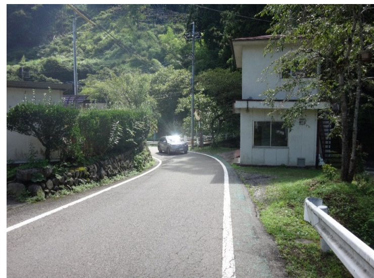
② 幅員が狭く、乗用車1台分が通れる幅員しかない
