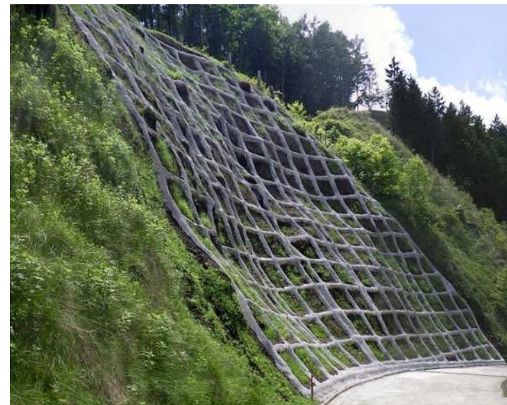
簡易法枠工の完成状況
