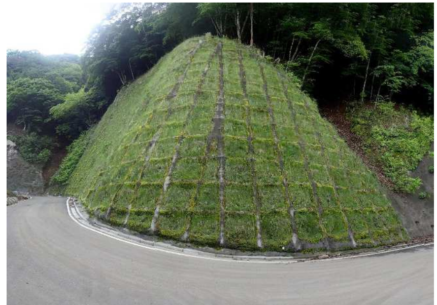
⑧ 法面保護工の実施状況
