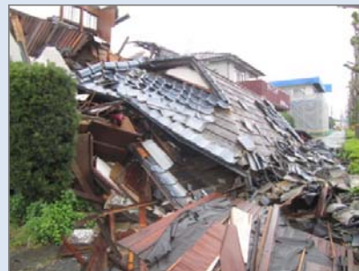
木造2階建て 被災状況
