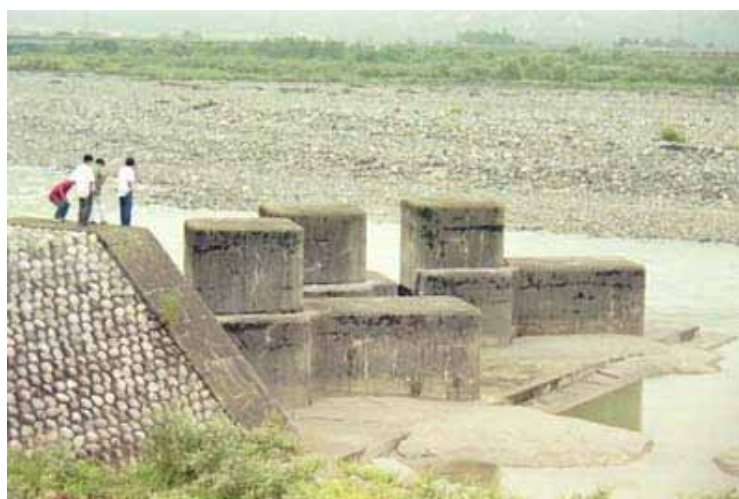
写真 5.4.1 黒部川のピストル水制（東京工業大学大学院池田研究室 HP より引用）
