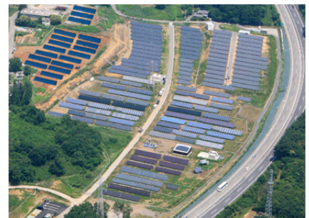
図8 ソーラーパネルの設置 出典：(株)NTT ファシリティーズ 東京ドーム 2 個分の敷地に太陽光パネルを設置しました。
