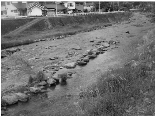
図 1 斜め堰による取水。手前が下流。左岸水路で取水するため斜め堰で水を導いている。
