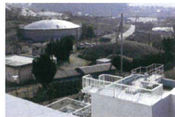
甲州市浄水場
