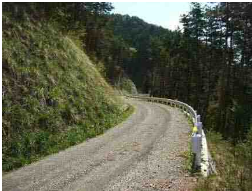
完成区間の状況（地形に沿った平面線形）
