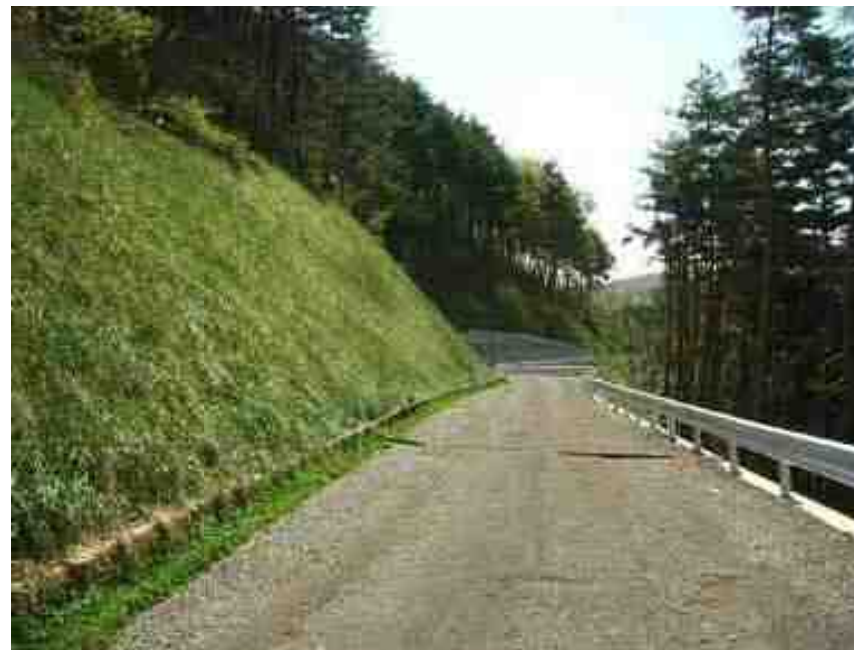
完成区間の状況（木製構造物の使用）
