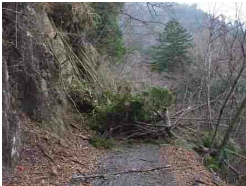
林道整備前の崩落状況
