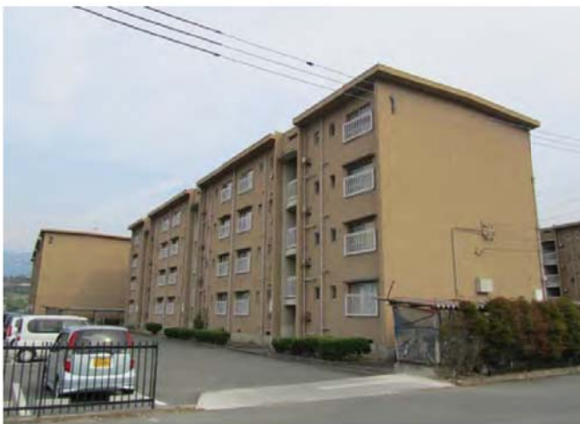
①既存建物外観写真
