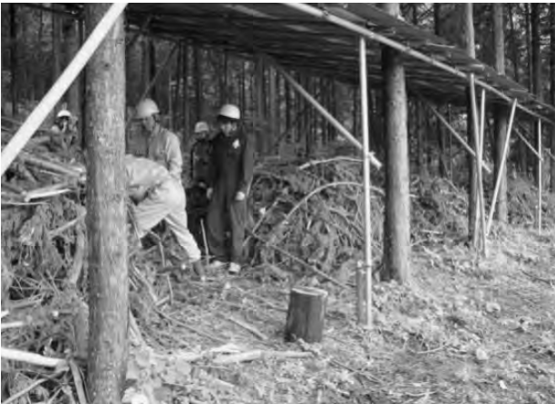
図5 設置した簡易屋根
