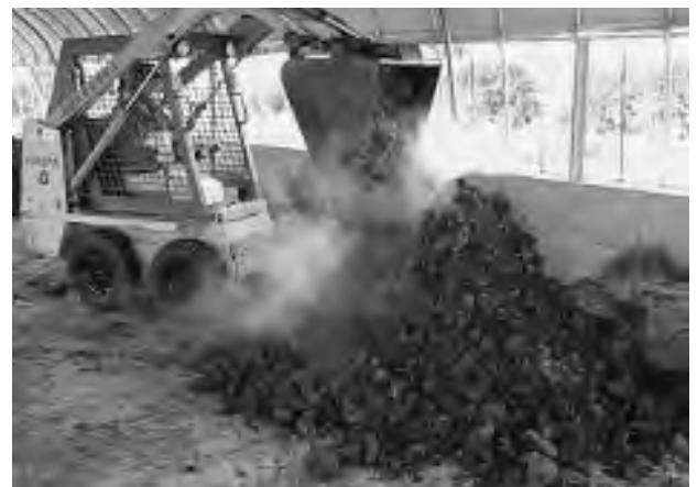
写真-6 重機による切り返し
