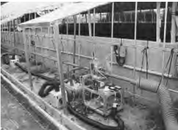
写真-17 悪臭分解装置を新堆肥舎に設置したところ
