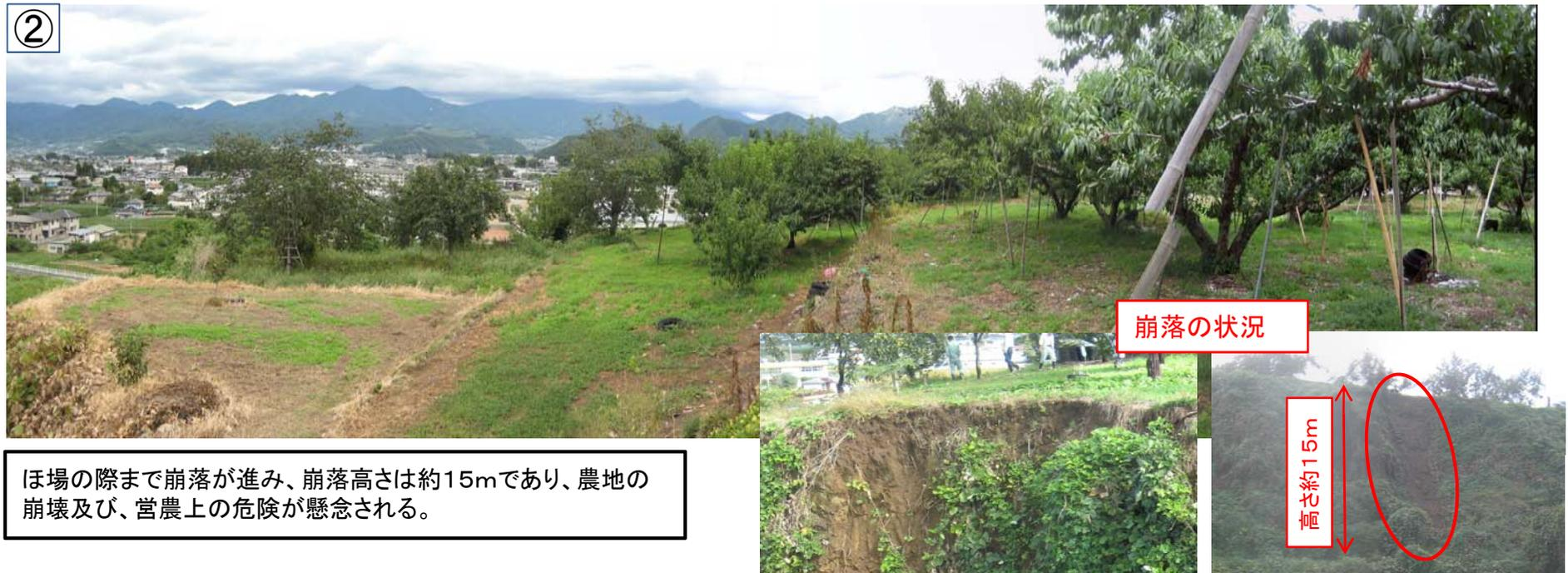
ほ場の際まで崩落が進み、崩落高さは約15mであり、農地の崩壊及び、営農上の危険が懸念される。
