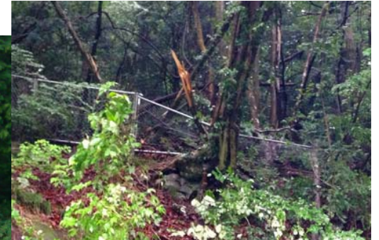
法面上部の崩落状況
