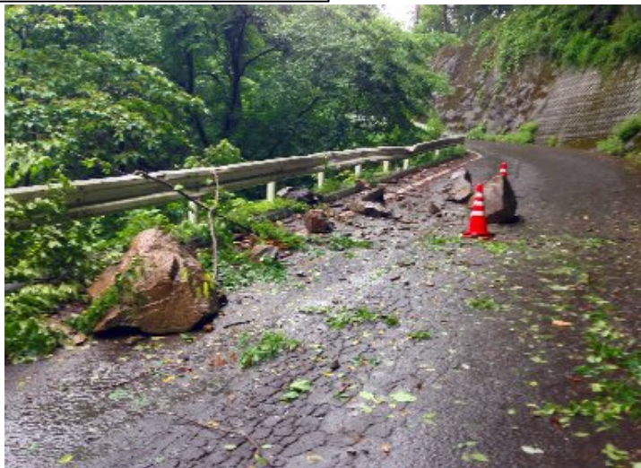
平成23年台風15号による落石状況(避難路が遮断)
