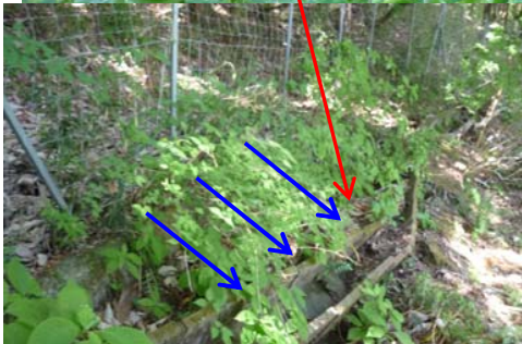
土砂崩落により水路が損傷
