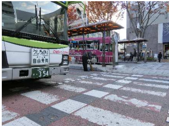
11月28日の作業状況
