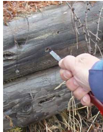
ドライバーを引き抜き貫入深さを計測します
