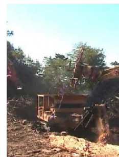
現地破碎の様子
