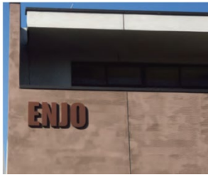
壁面と同系色を用い、 整った印象を与えている
