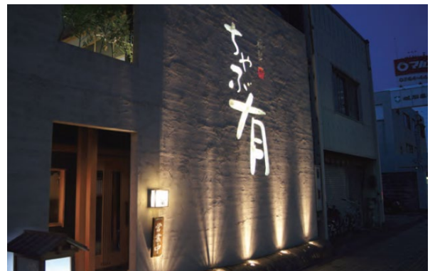
床から上方向に外壁を照らすことで、印象が変わるシンプルな外壁⑦
