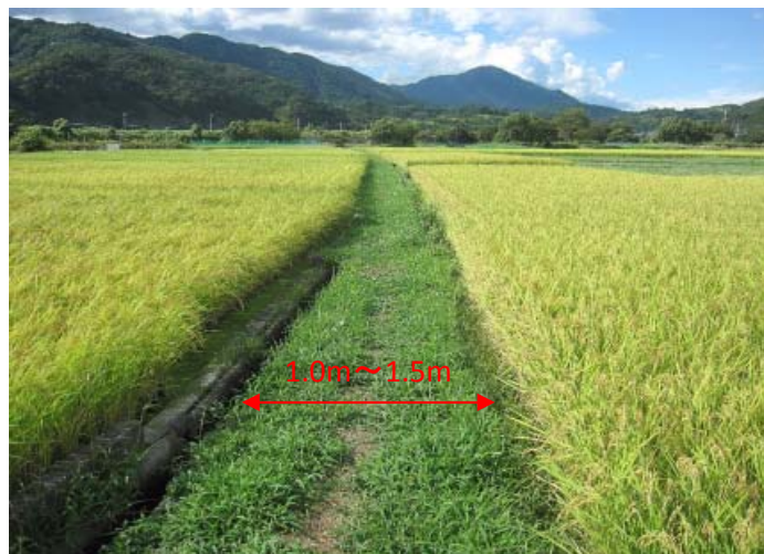
①道路幅が狭小な上、未舗装のため農業資材の搬入や農産物の搬出が困難な農道
