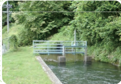
② 山を通過する 水路トンネル
