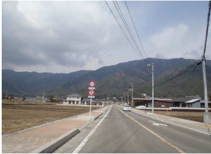
河口湖精進線交差点部から若彦トンネル方面を望む
