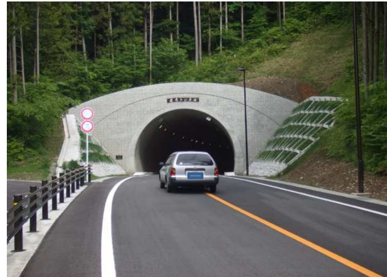
若彦トンネル芦川側坑口
