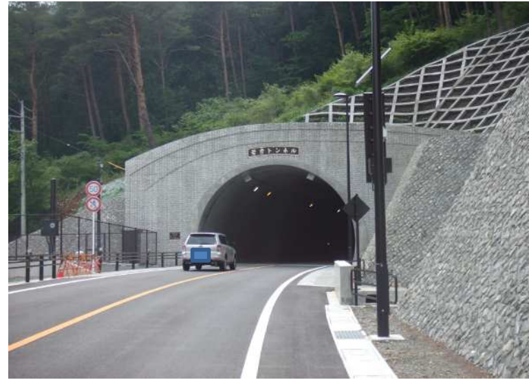
若彦トンネル河口側坑口
