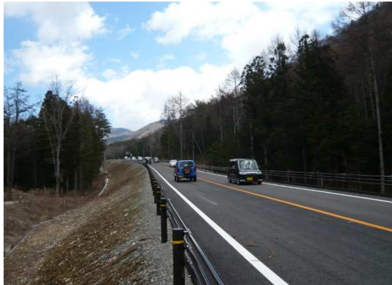
芦川終点部から若彦トンネル方面を望む
