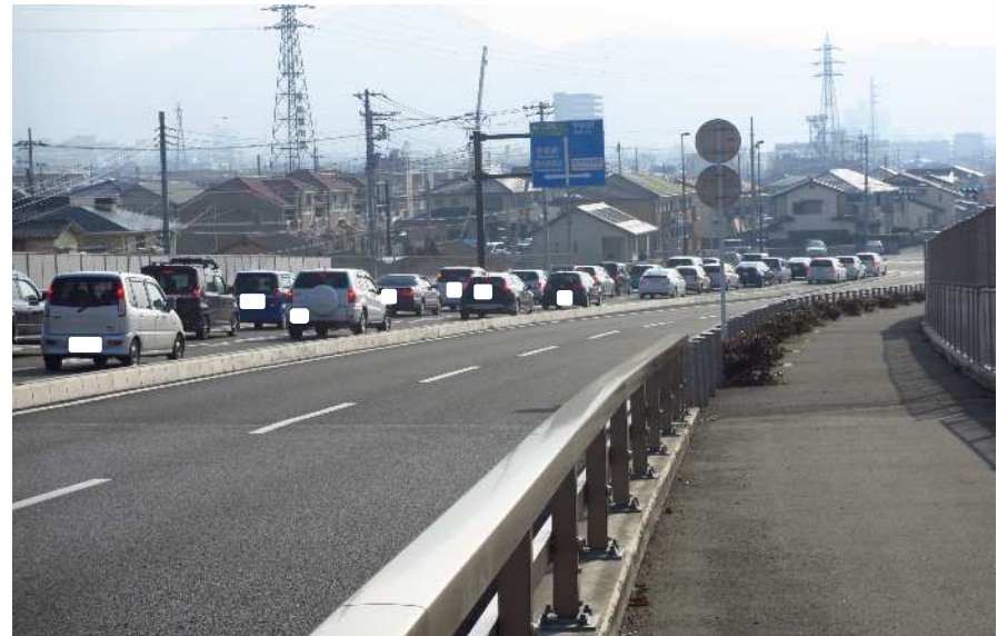
写真 整備済み状況 (富士見大橋から起点側を望む)
