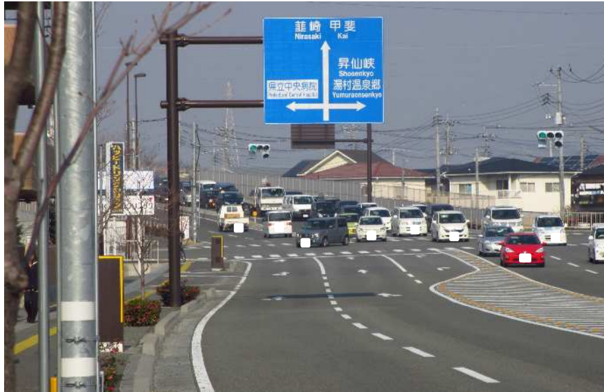
写真 整備済み状況 (起点から富士見大橋東側を望む)
