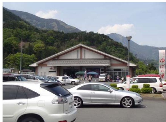
活性化施設全景
