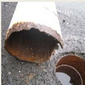
ポール看板の倒壊
