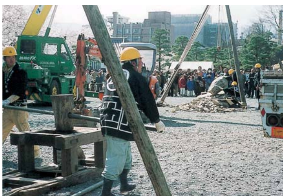
昔ながらの石積の再現 手前がかぐらさん、奥で石を積む作業を披露しています
