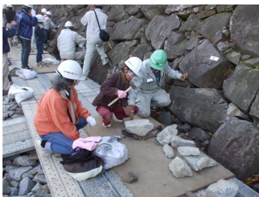
写真:「ハツリ」作業
