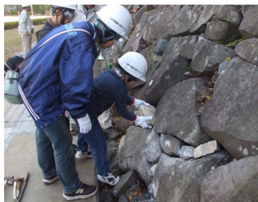
写真:詰石作業
