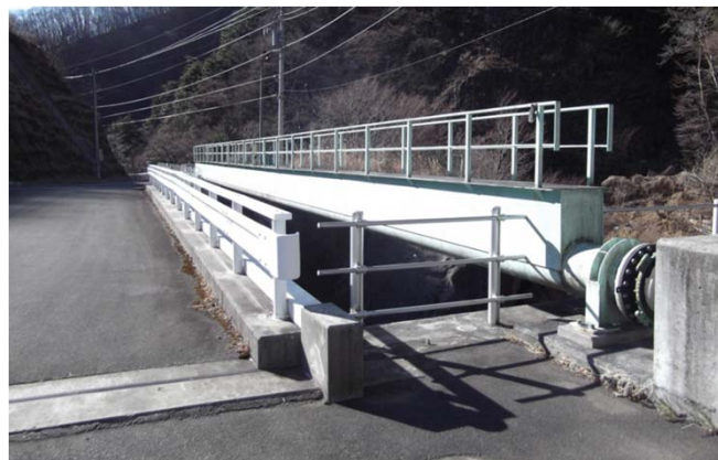
管路工 (水管橋) (塩川ダム直下放水路)
