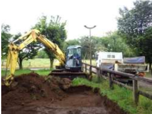
写真：土を掘っている様子
