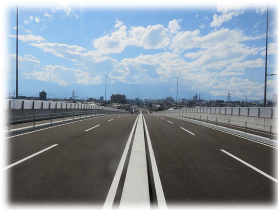
国道 411 号 城東Ⅱ期バイパス（平成 29 年度供用開始）
