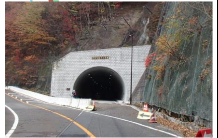
至 東京都 ②東京都側坑口
