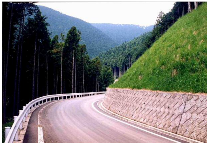
①林道の開設状況
