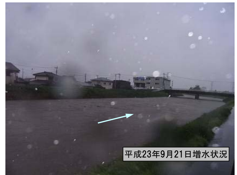
出水写真④ 大黒橋上流
