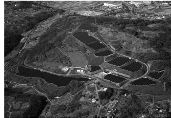
米倉山太陽光発電所
