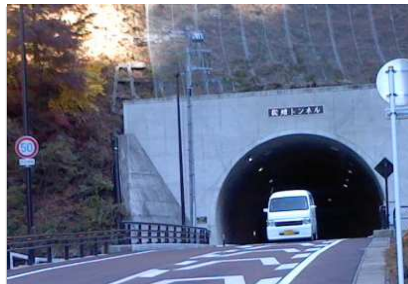
④ 車両の通行状況(大月側)
