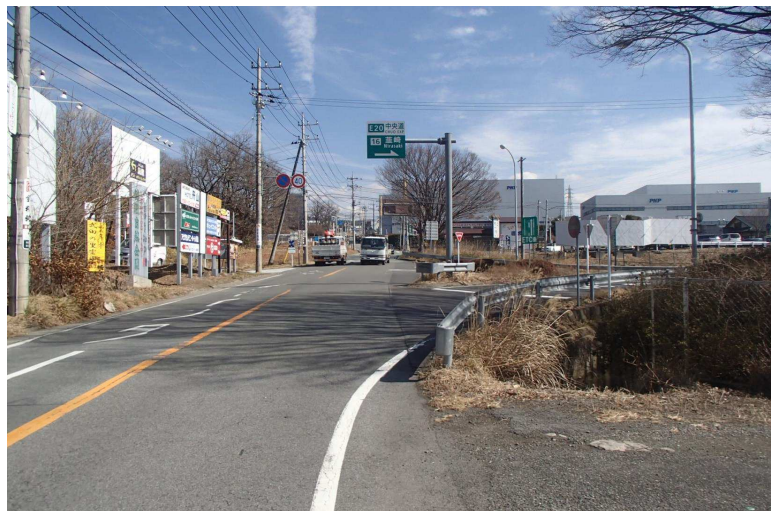
③荊崎インターチェンジ交差点付近の状況
