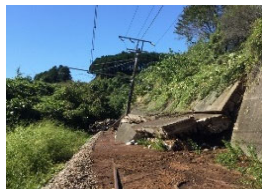
【国道20号】被災状況(倒木) 【中央道】被災状況(土砂崩落) 【JR中央本線】被災状況(土留壁崩壊)
