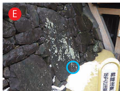
鉄門脇の石垣：未使用の矢穴 鉄門の脇にひっそりとある、ひとき ろ大きな目立つ石に彫られた矢穴。
