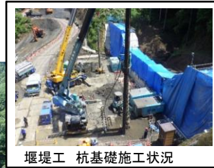
堰堤工 杭基礎施工状況
