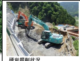
硬岩掘削状況
