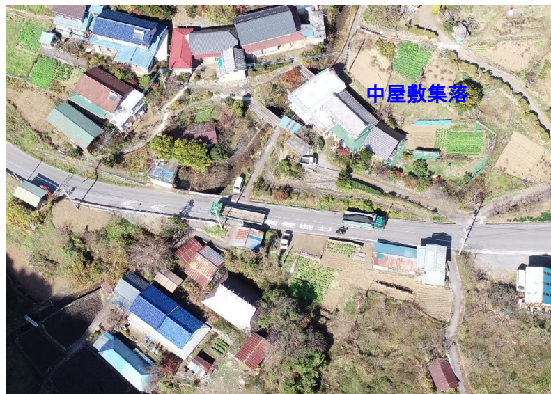
③ 幅員の不足 すれ違い困難な状況
