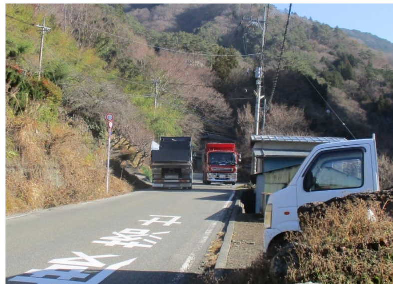
④ 幅員の不足 すれ違い困難な状況
