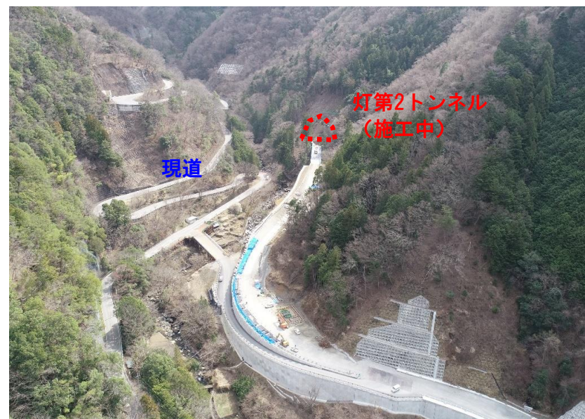
⑥ 進捗状況(バイパス区間中間部付近) ～ヘアピンカーブの現道とバイパス区間～
