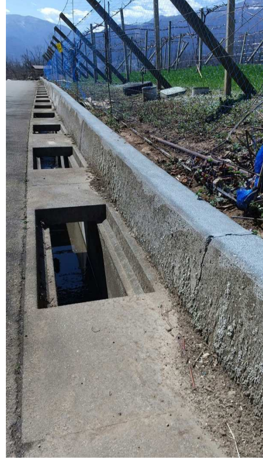
◀ 柵の下がコンクリで電気柵のアースが確保できない(灰色部分)
