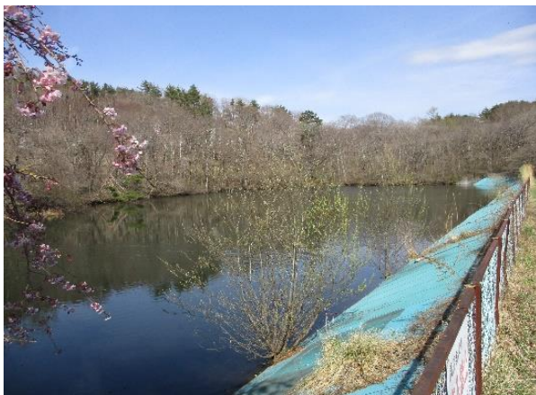
① 井富ため池 全景 貯水量 18,000m 3 、堤高 H=4.8m
