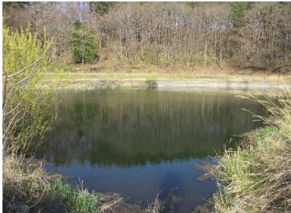
① 平井出ため池 全景 貯水量 2,800m 3 、堤高 H=5.1m
