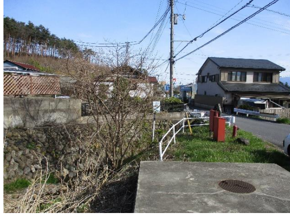
② ため池下流には中央自動車道や鉄道、人家があり、大規模地震の際には甚大な被害のおそれがあるため、早急に対策を講じる必要がある。
