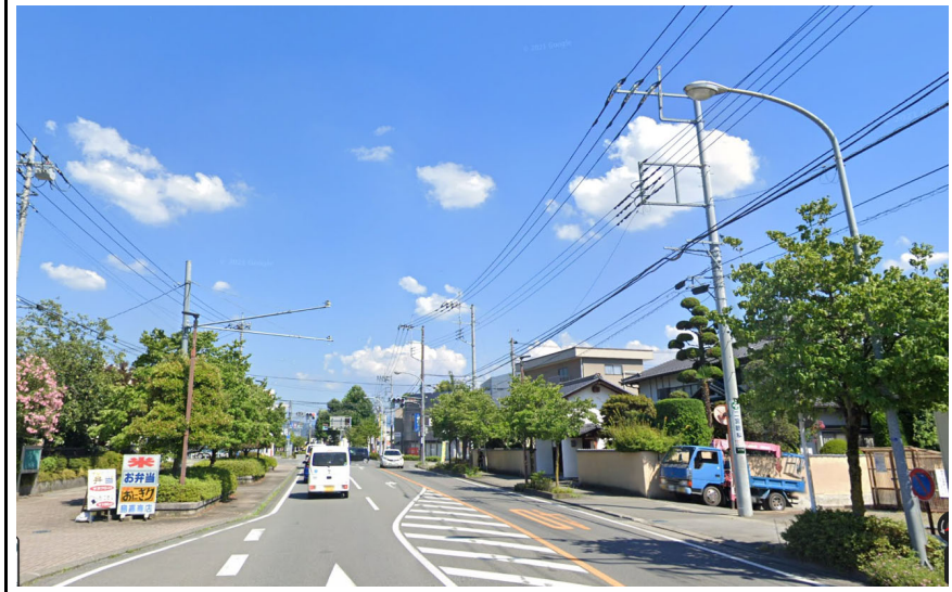
【写真②】 電柱、電線類の状況
